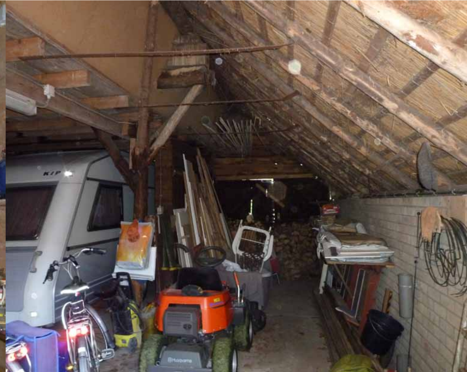
foto 8 schuur gezien binnen, opslag-/ stallingsgedeelte
