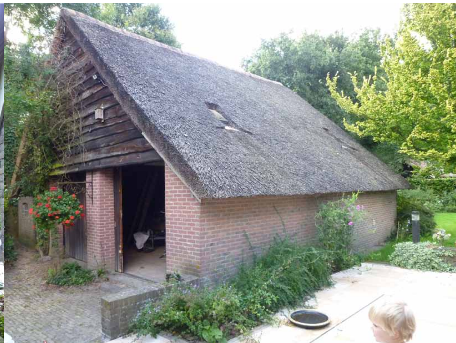
foto 2 schuur naast terras , gezien vanuit terras
